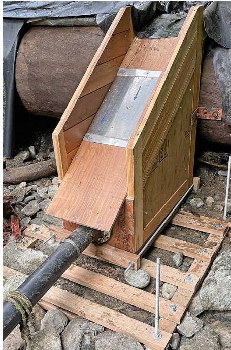
Caja de entrada de agua, en el Arroyo Marble
