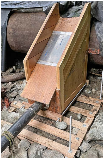
Caixa de entrada d'água, no Arroio Marble
