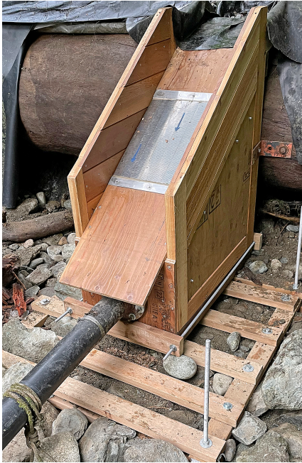
Caixa de entrada d'água, no Arroio Marble
